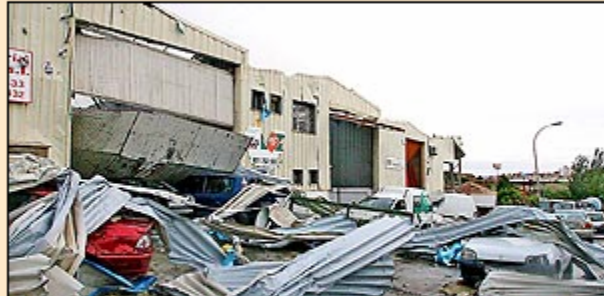
En el polígono de Can Valero el desastre fue mayúsculo: volaron los tejados de algunas naves y decenas de coches quedaron destrozados. Foto: SEBASTIÀ AMENGUAL
